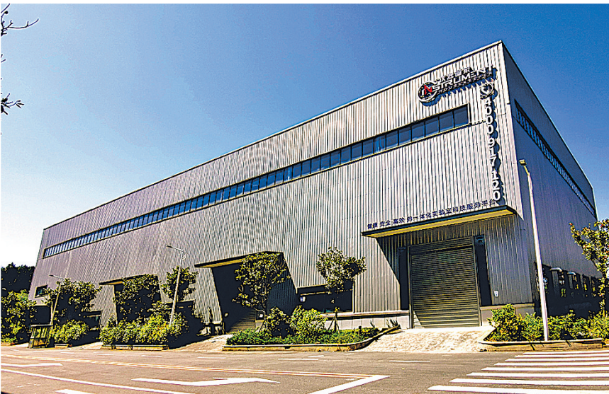
位于贵州科学城的贵州省重大科研基础设施和大型科研仪器共享信息服务平台。
