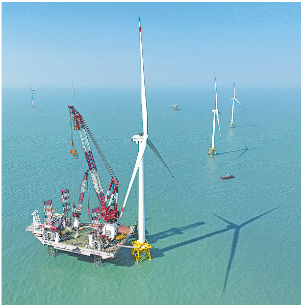
2026年1月13日在福建海域拍摄的20兆瓦海上风电机组和“大桥海风”号2000吨自升式海上风电安装平台(无人机照片)。
