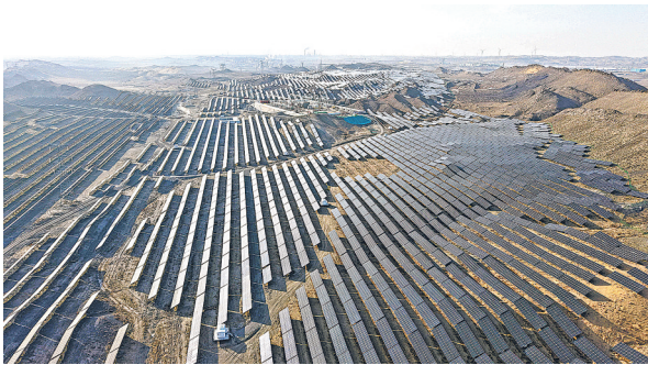
位于宁夏中卫市腾格里沙漠边缘的大唐中卫云基地数据中心绿电供应200万千瓦新能源项目(2026年2月10日报，无人机照片)。
