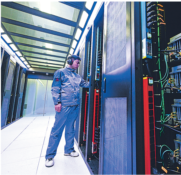
2026年6月4日，在位于内蒙古呼和浩特市和林格尔新区的内蒙古中科超算科技有限公司，工作人员巡检算力设备。
