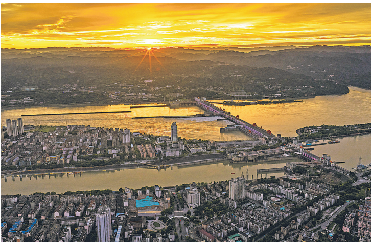
2026年6月8日，夕阳映照在三峡水运新通道工程葛洲坝航运扩能施工现场。
