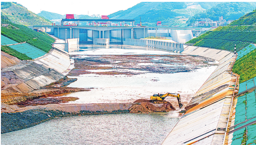
2026年6月3日拍摄的广西平陆运河马道枢纽水闸现场(无人机照片)。
