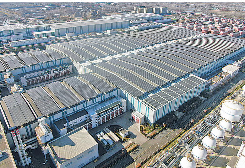
位于山东省临沂市临港经济开发区的光伏发电项目(2025年11月27日摄，无人机照片)。
