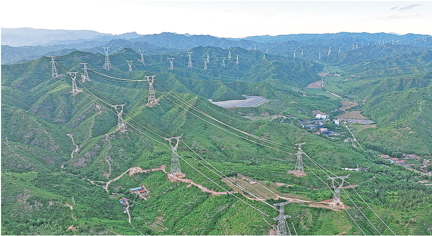
位于河北省承德市丰宁满族自治县的大同—怀来—天津南1000千伏特高压输电线路工程施工现场(2026年6月17日摄，无人机照片)。
