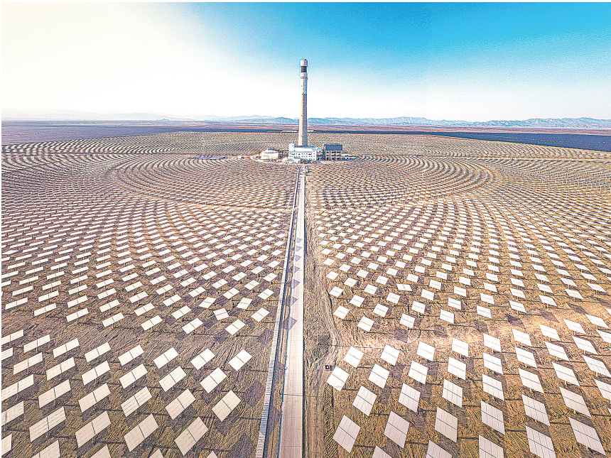
位于新疆吐鲁番市鄯善县的1GW“光热+光伏”一体化项目(2025年7月28日摄，无人机照片)。
