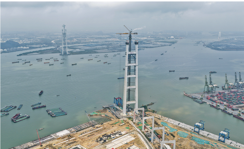
2026年3月26日拍摄的粤港澳大湾区核心枢纽工程狮子洋通道关键控制性工程——狮子洋大桥东、西主塔(无人机照片)。
