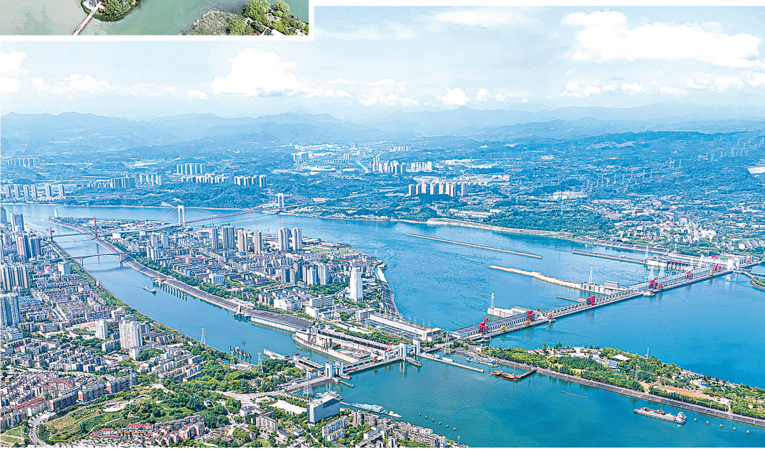
▼在湖北宜昌,船舶经过葛洲坝水利枢纽工程水域(2026年5月14日摄,无人机照片)。
