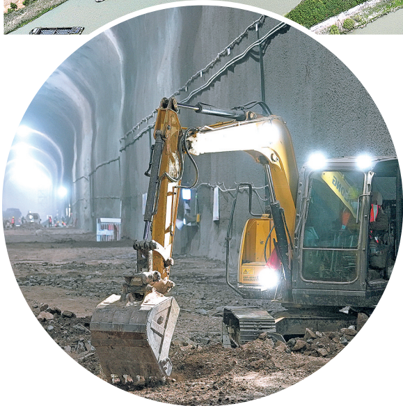
黄河古贤水利枢纽导流洞内景(2025年12月27日摄)。
