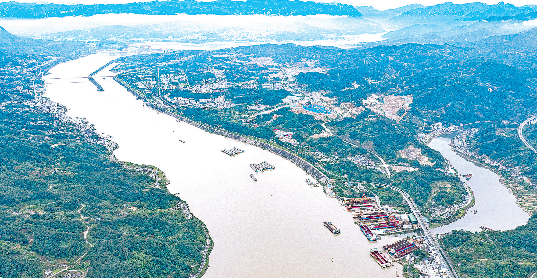
三峡水运新通道工程三峡枢纽新通道施工现场(2026年6月8日摄)。
