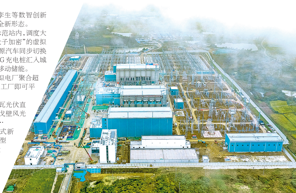
安徽合肥州换流站(2025年10月16日摄，无人机照片)。
